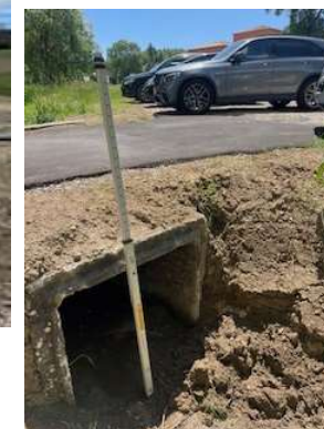
Installation buse passage du 9 au 10
